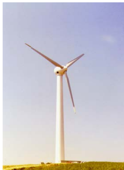
Figura 13. Aerogenerador con generador síncrono de imanes permanentes de flujo radial de 660 kW de potencia (GENESYS) y axial de 750 kW (JEUMON J48)
